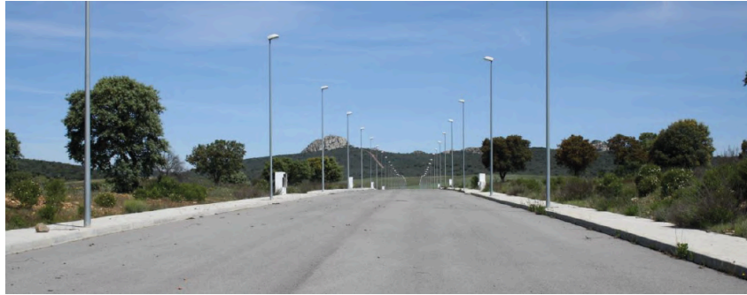
Estado actual del polígono: vial central, urbanizado y sin edificación.
